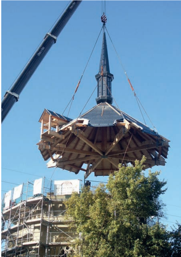
Montage des neuen Daches am 24. Oktober 2002
